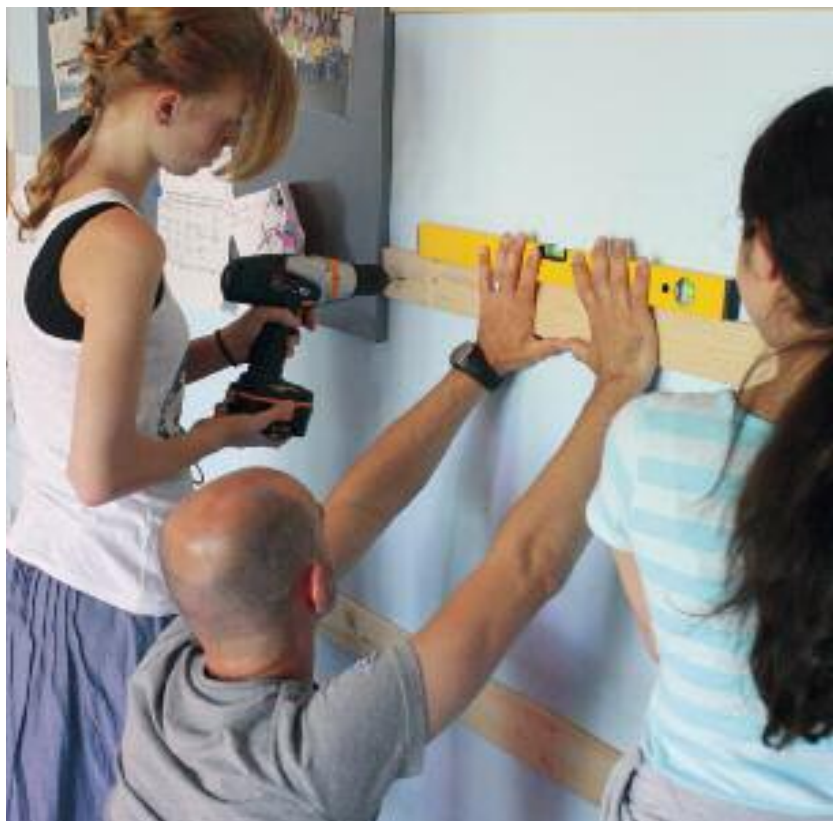
Umgang mit dem Akku-Schrauber: Zwei Schülerinnen bringen mit Unterstützung von Herrn Lehr Leisten im Klassenraum an
